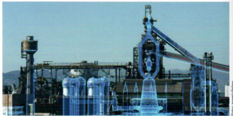
Der generalüberholte Hochofen von voestalpine in Linz in einer Mixed-Reality-Aufnahme, bei der die gesammelten Daten von vier Drohnen digital ins Bild eingefügt wurden.
